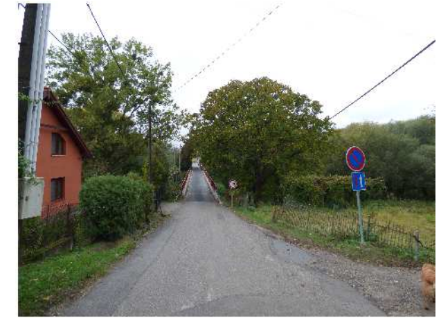
- pohľad smerom dole na most
